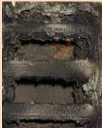
Verharzte Kanalklappe – übersättigter Zuluftfilter – Fett überzogene Küchenabluft
