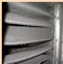
Verharzte Kanalklappe – übersättigter Zuluftfilter – Fett überzogene Küchenabluft
